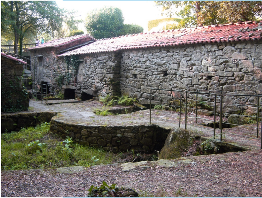
Vista do conxunto do Mosquetín. Están montados de tal xeito que a segunda fileira aproveita a auga que fai funcionar a primeira.
